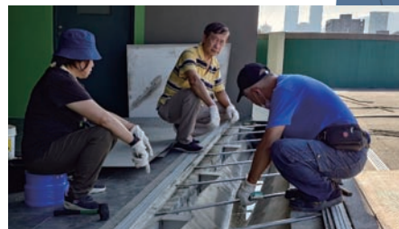
修繕伸縮縫蓋板
