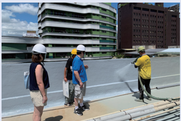
校長視導本大樓防水工程
