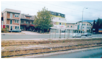
塞拉耶佛市內基礎設施有進步空間，從輕軌道間雜草叢生事知。
