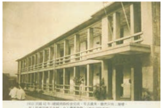
建國南路校舍第一期工程完成，正式遷入新的校舍。
